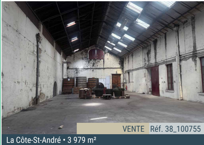
VENTE Réf. 38_100755 La Côte-St-André • 3 979 m 2 A vendre local d'activité sur un terrain de plus de 11 000 m 2 Local d'activité de 3 979 m 2 de SDP, sur plus de 11 000 m 2 de terrain, idéal pour développer une activité artisanale, de production ou de stockage. Travaux à prévoir afin d'adapter ce bien à votre activité. Disponibilité : immédiate
