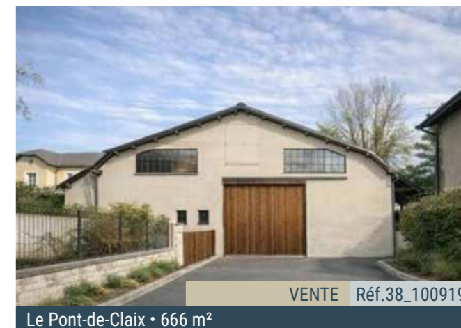
VENTE Réf.38_100919 Le Pont-de-Claix • 666 m 2 Bâtiment à usage d'activités Situé sur la commune de Pont-de-Claix, ce bâtiment à usage d'activités est édifié sur une parcelle de 945 m 2 . Traversant, il dispose de deux portes industrielles de part et d'autre du bâtiment. Disponibilité : immédiate
