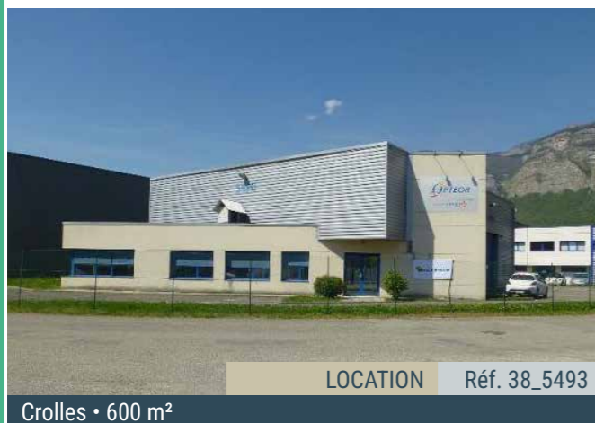
LOCATION Réf. 38_5493 Crolles • 600 m 2 Local d'activités indépendant avec prestations de qualité Local d'activités indépendant de 600 m 2 au sein d'un bâtiment récent offrant de belles prestations, dont un pont roulant de 20 tonnes, sur une parcelle close de 1 640 m 2 . Disponibilité : immédiate
