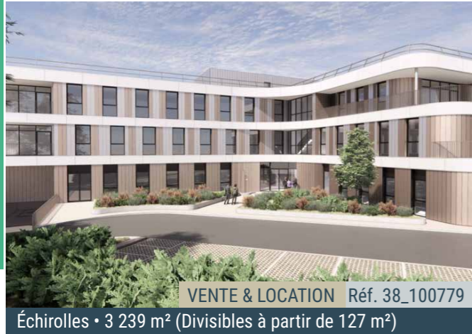
VENTE & LOCATION Réf. 38_100779 Échirolles • 3 239 m 2 (Divisibles à partir de 127 m 2 ) EPURE : Programme neuf dans le parc Sud Galaxie Programme de bureaux / laboratoires neuf, idéalement situé au sein d'un parc tertiaire fermé et sécurisé. Environnement arboré et terrasses privatives. Proche gare SNCF d'Échirolles et rocade Sud. Livraison : 24 mois après signature
