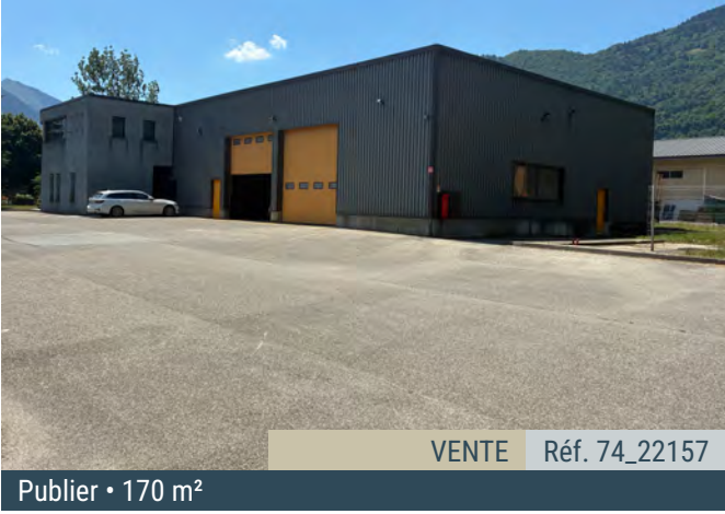
Publier • 170 m 2 VENTE Réf. 74_22157 Bâtiment neuf Cellule d'activité neuve de 170 m 2 dans la ZI Les Genevilles, livrée brute de béton, réseaux en attente, HSP 5,90 m et 3 places de stationnement incluses. Disponibilité : immédiate
