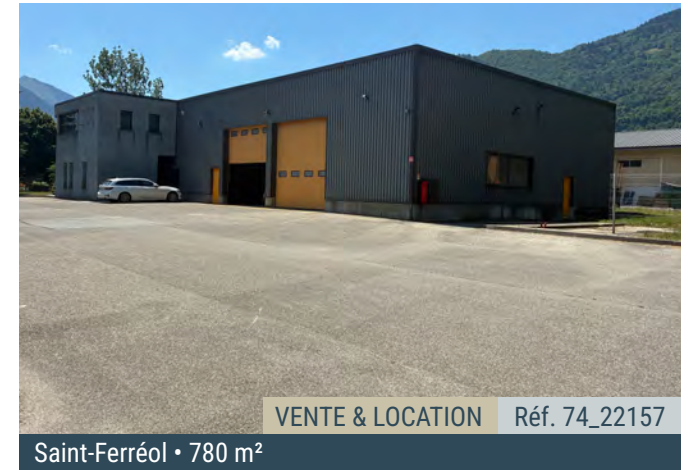
Saint-Ferréol • 780 m² VENTE & LOCATION Réf. 74_22157 Bâtiment d'activité indépendant Bâtiment de 780 m² comprenant 386 m² d'entrepôt, 259 m² de bureaux et 135 m² de mezzanine, avec 2 portes sectionnelles, fosse et plus de 20 places. Disponibilité : immédiate
