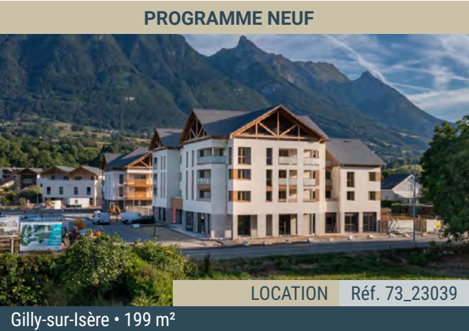
Gilly-sur-Isère • 199 m² LOCATION Réf. 73_23039 Local commercial neuf au cœur d'un nouveau quartier À Gilly-sur-Isère, une cellule commerciale neuve de 199 m² au cœur du futur quartier Cœur de Village . Livrée brute avec fluides en attente et vitrine posée, idéale commerces et services de proximité. Disponibilité : immédiate
